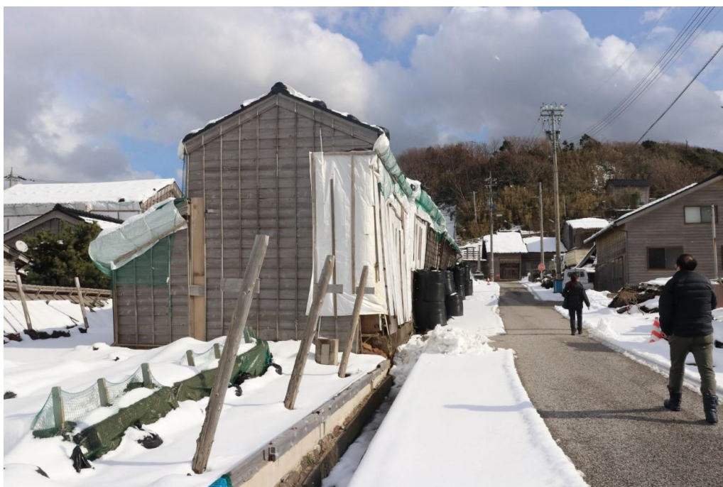
被災した輪島市黒島の重要伝統的建造物群保存地区
