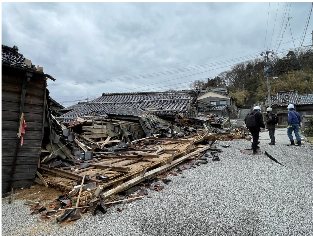
倒壊した国指定重要文化財 旧角海家住宅（輪島市、2024年2月2日）
