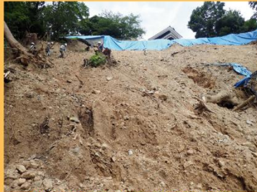
2024年7月の大雨による松山城斜面崩壊 (2024年7月24日撮影)
